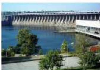
Дніпрогес Дніпровська гідроелектростанція
